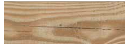
Trocknungsrisse (nach DIN zulässig)
